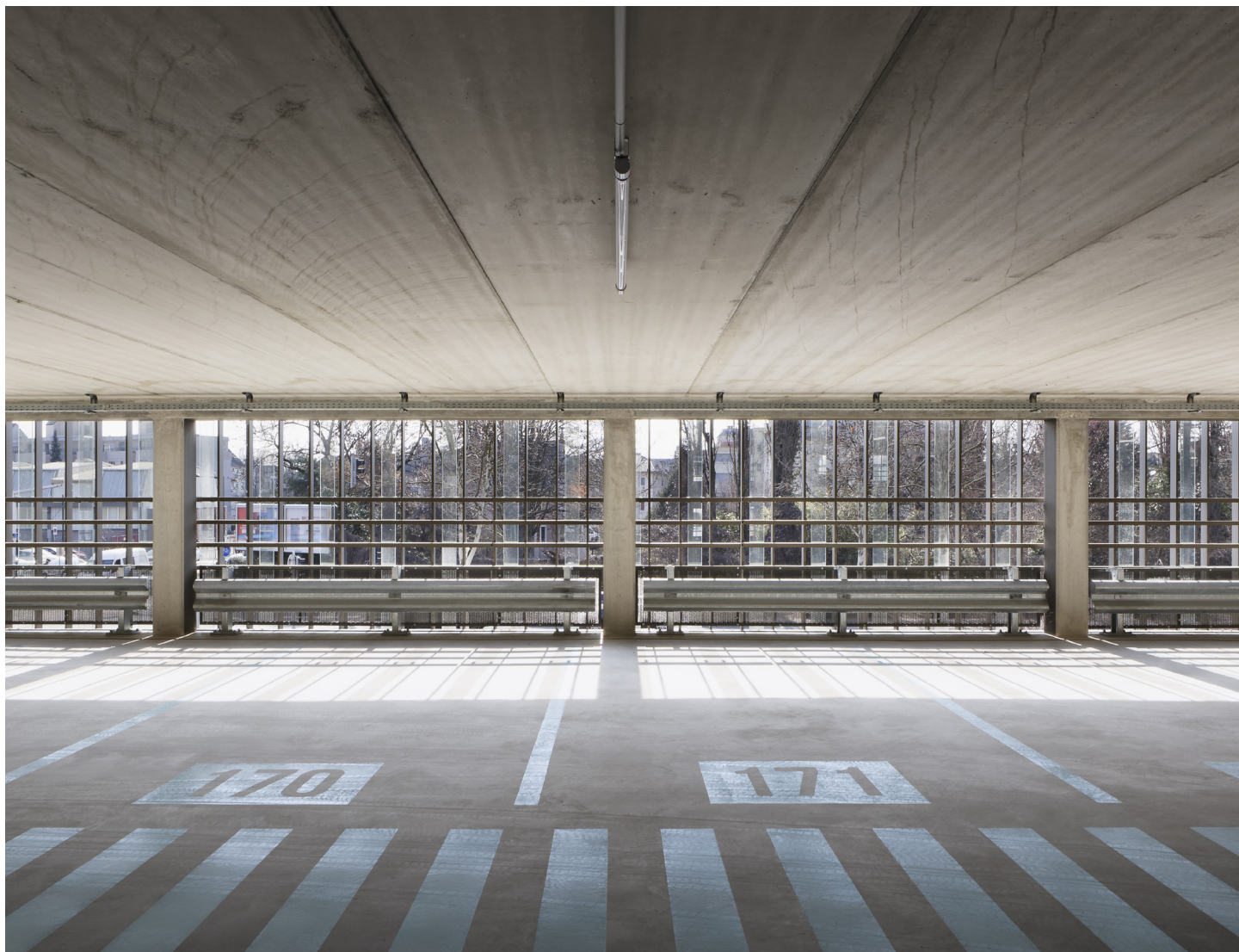
Lumière et air : la structure de béton libère de grandes ouvertures ; le verre, cristallin, disparaît Danube Vert, premier niveau
