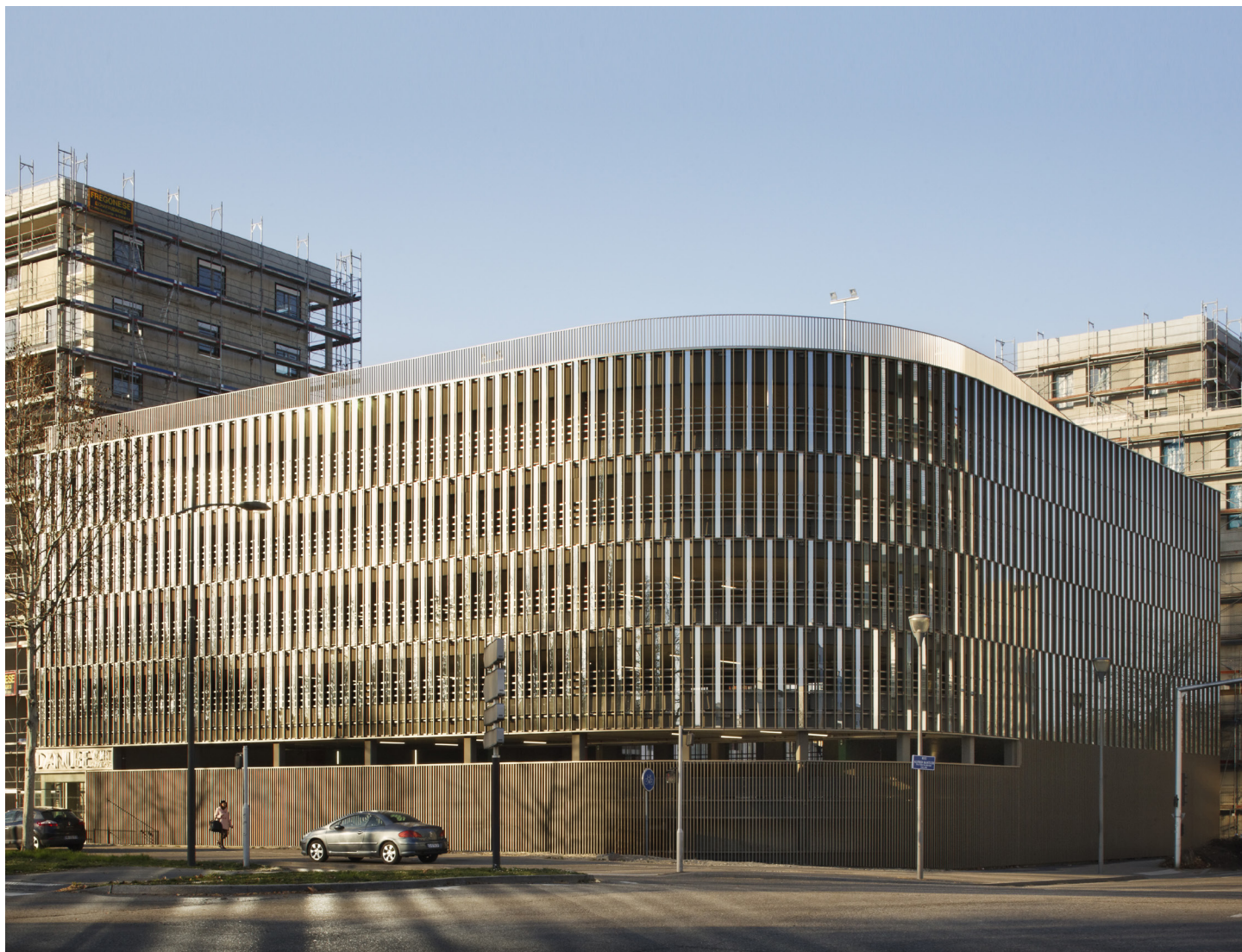
La façade du parking compose un assemblage frugal de béton drapé d'acier et rehaussé de verre qui reflète le paysage. Danube Vert, angle de l'avenue du Rhin et de la rue Alfred Kastler
