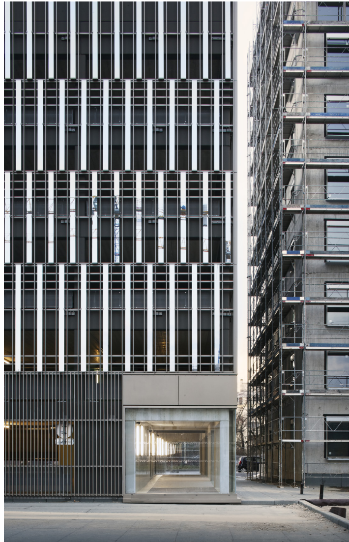
Tel un passage, le hall piéton traverse visuellement le bâtiment depuis l'avenue du Rhin jusqu'au cœur d'îlot Danube Vert, cœur d'îlot
