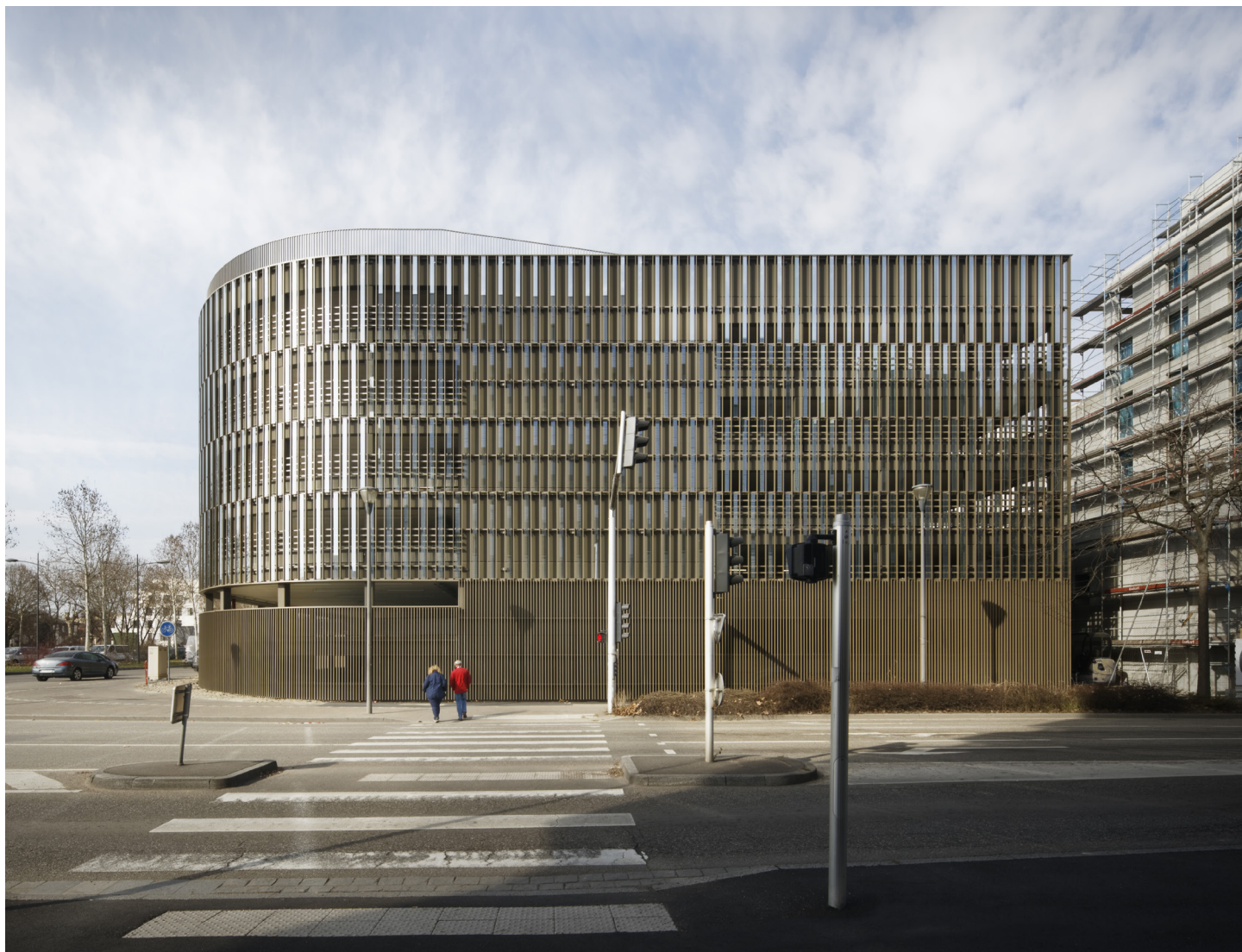
Les teintes bronze de la serrurerie ressortent sur le fond sombre du béton lasuré et répondent aux reflets du verre. Danube Vert, rue Alfred Kastler
