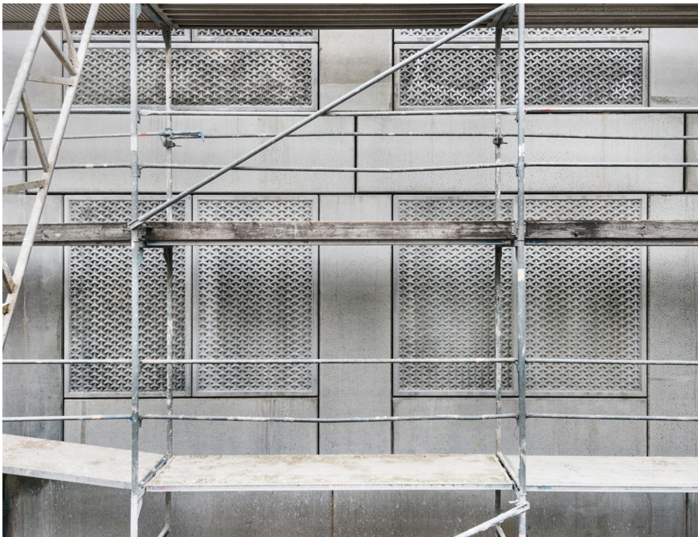
En chantier : bétons brut et matricé Programme mixte logements-bureaux de COSA
