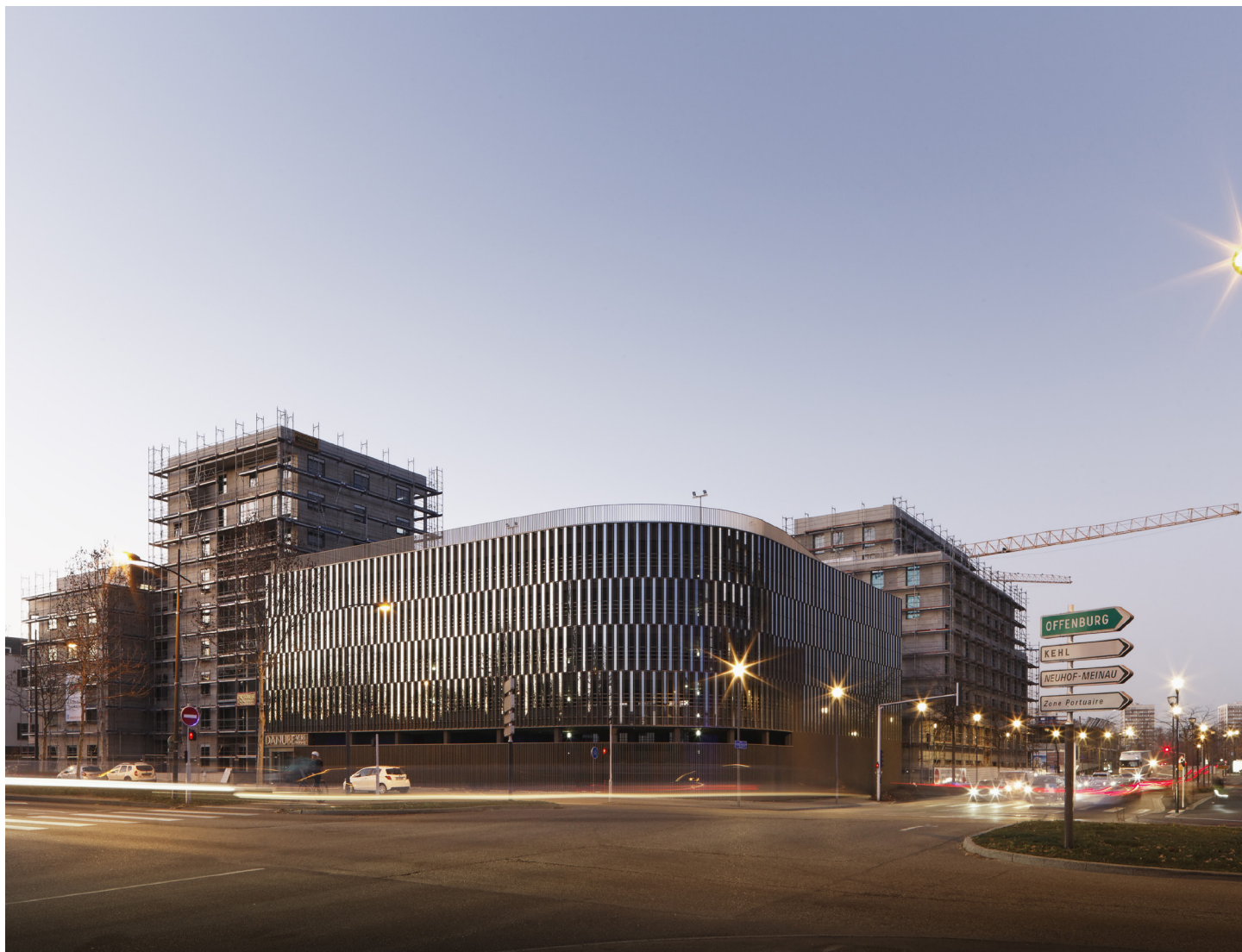
L'îlot-I et Danube Vert en sa proue, marquent l'entrée de l'écoquartier strasbourgeois et posent la question de l'évolution des modes de transports, de la place de la voiture. Danube Vert, angle de l'avenue du Rhin et de la rue Alfred Kastler
