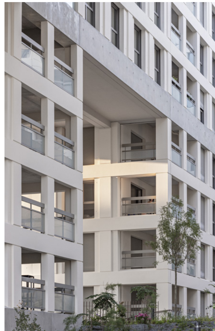
À l'échelle du piéton, le traitement du socle, les aménagements paysagers, les percées vers le jardin ou les halls, le rythme des moucharabiehs, rendent le bâtiment appropriable.
