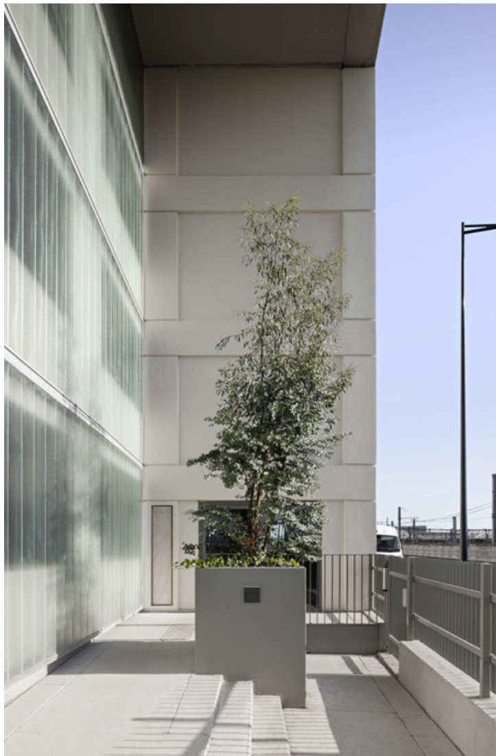
Sa façade largement ouverte est habillée de verre profilé armé.
