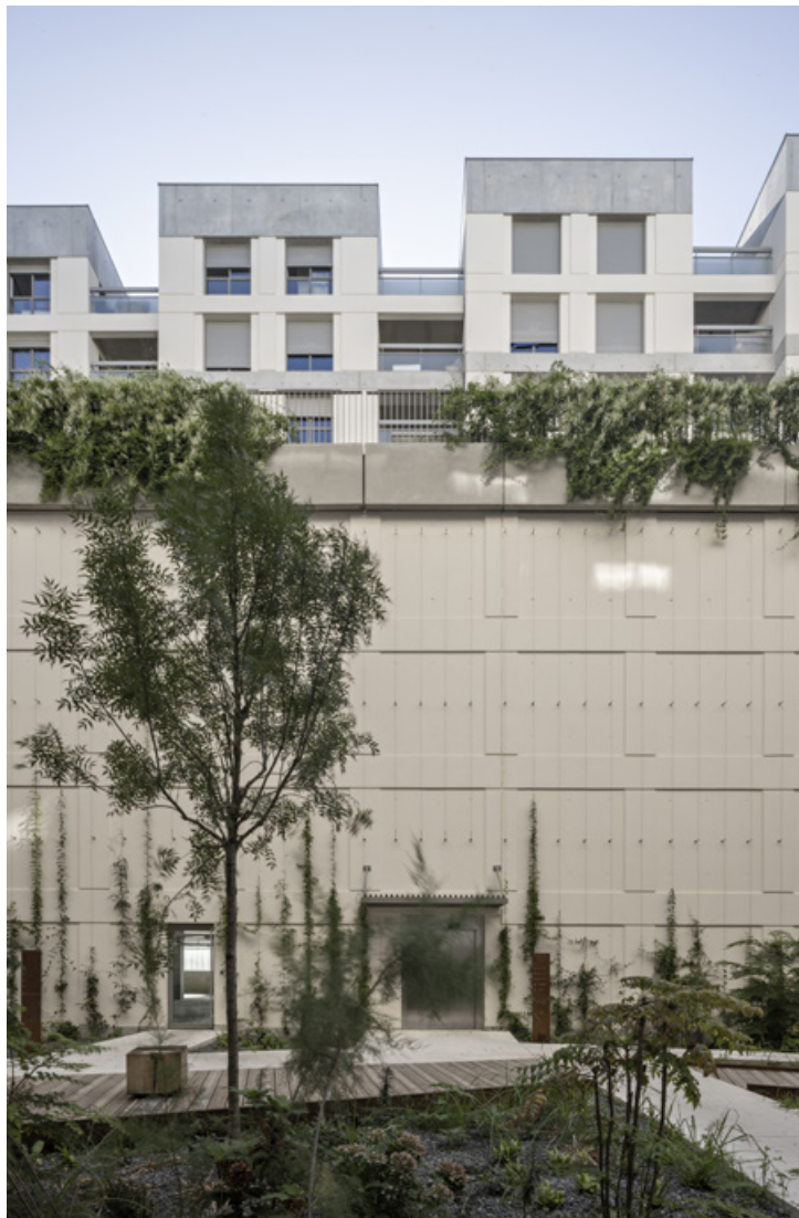
Dans le jardin, le parking se fait discret, petit à petit, la végétation le recouvre.
