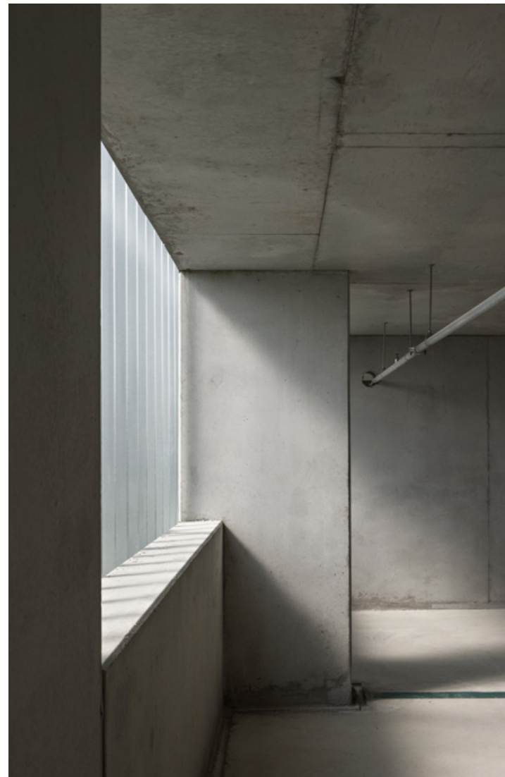
A l'intérieur du parking, il apporte une lumière tamisée qui crée un clair-obscur mettant en lumière le parking.
