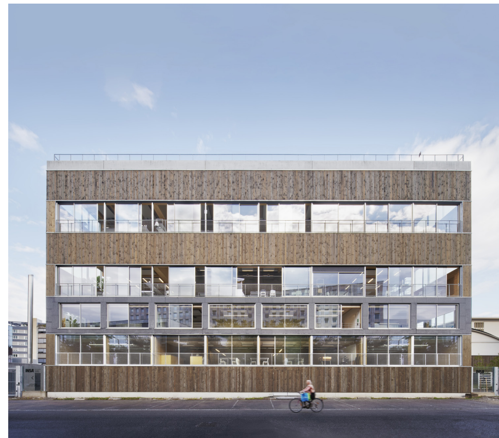
Construction de l'École d'architecture et restructuration, en site occupé, en deux phases, de l'Institut National Des Sciences Appliquées de Strasbourg (67)
